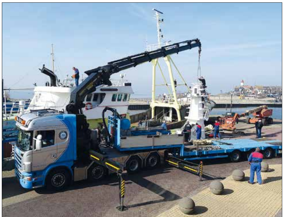
De VCU-TCD herstelde dit jaar zware aanvaringsschade bij de NG 1.
